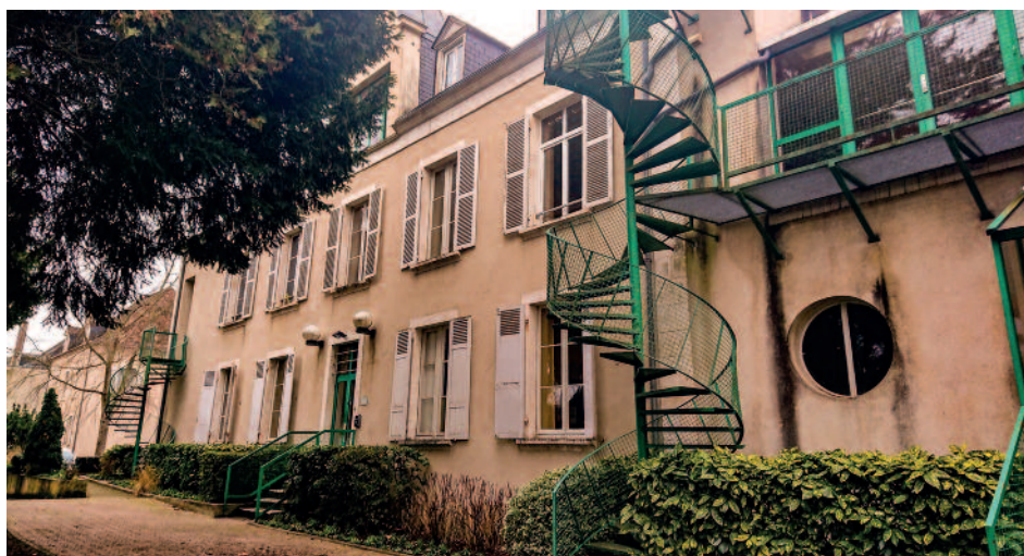
La façade arrière de la mairie.
